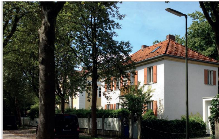
Die zu sanierende Villa auf dem vorderen Grundstück
